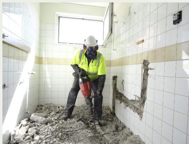
Figur 1. Uppbilning av avloppssystem.
